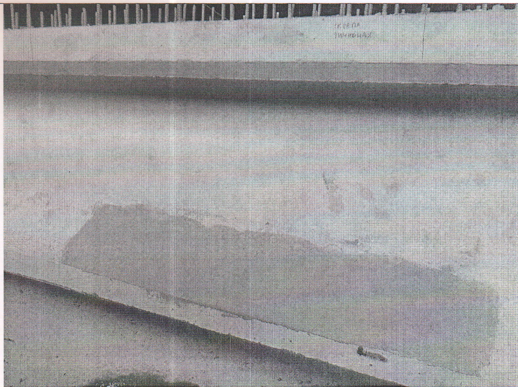
Заполнение каверн поверхности балки
